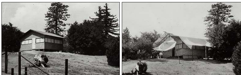
Домик Дейтона Миллера для эфирных измерений на Маунт Вилсон, 1920-е гг. Окна, закрытые бумагой, были расположены в плоскости светового пути интерферометра. На правом снимке этот же домик, прикрытый тентом для выравнивания температуры. http://www.orgonelab.org/miller.htm
